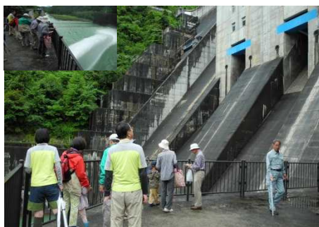
ダム内部見学(ゲート監視所)
