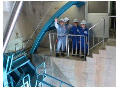
●機械設備の点検
