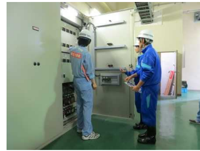
●電気設備の点検
