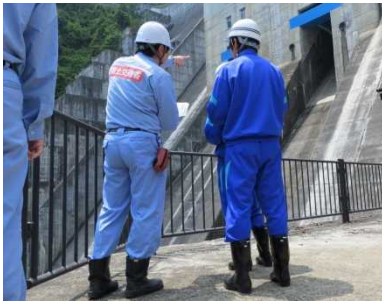
●ダム堤体の点検
