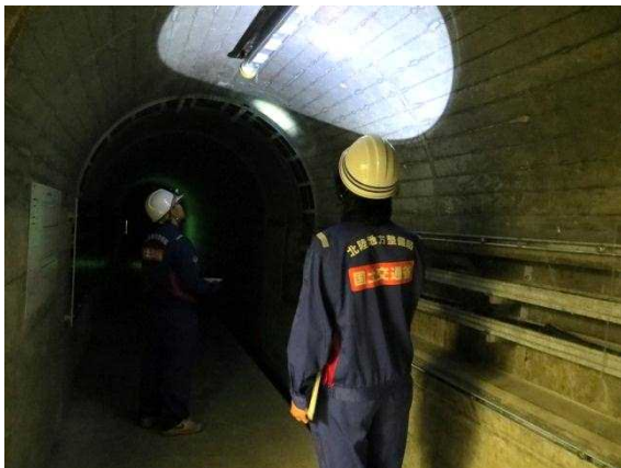
ダム堤体内点検
