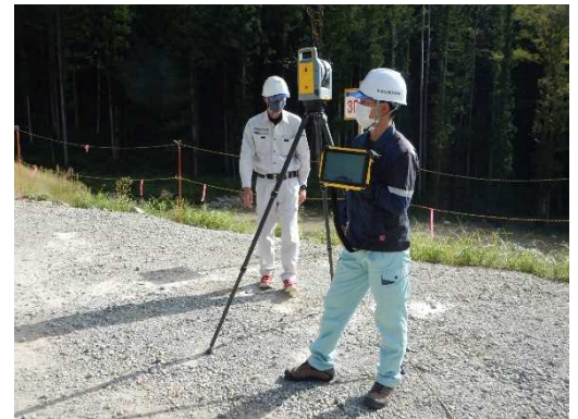
3Dレーザースキャナーによる測量デモ
