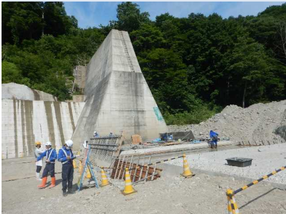
工事現場のパトロールの状況
