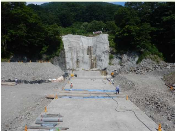
工事現場のパトロールの状況
