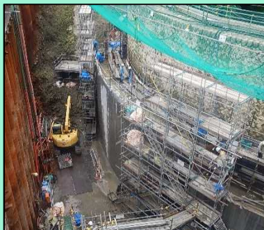
コンクリート堰堤施工状況
