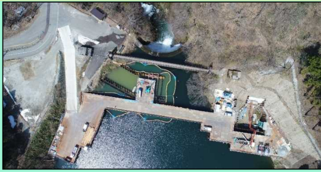
平成30年4月(仮締切施工中、仮排水トンネル完成)
