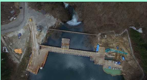
平成29年4月(仮棧橋完成、仮排水トンネル着手)
