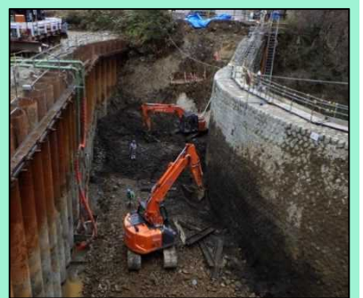
堰堤掘削状況
