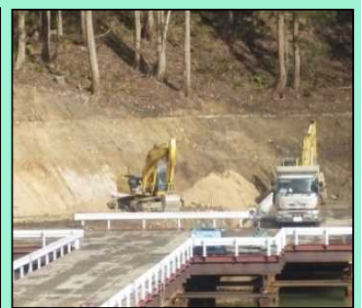
右岸ヤード造成状況
