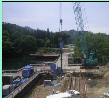
トンネル呑口施工状況
