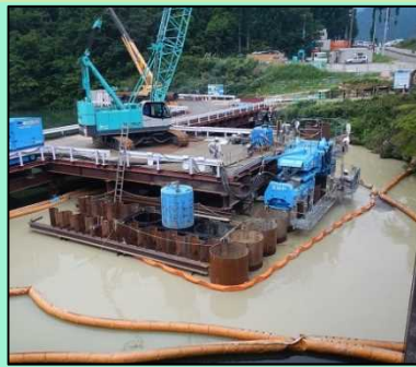
仮締切鋼管杭施工状況
