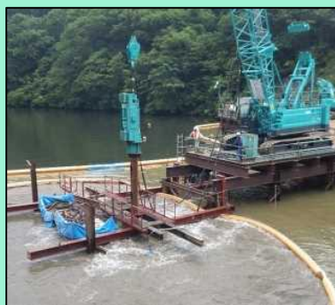
仮棧橋施工状況
