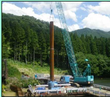
仮締切鋼管杭施工状況
