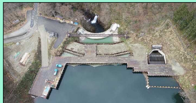
令和2年12月(コンクリート堰堤完成)
