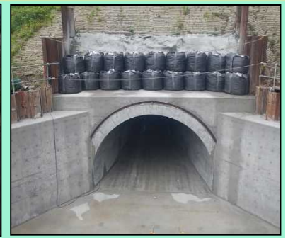
仮排水トンネル完成
