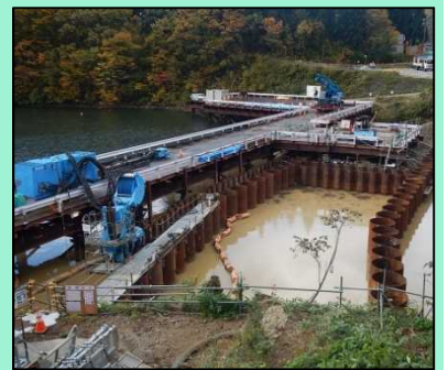
仮締切鋼矢板施工状況
