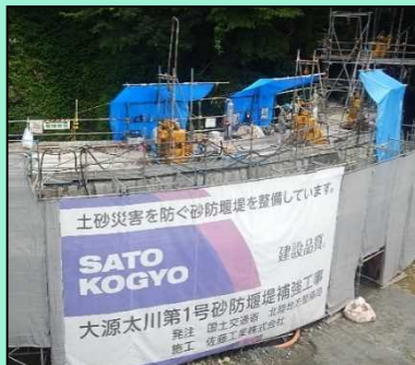
既設堰堤補強工施工状況
