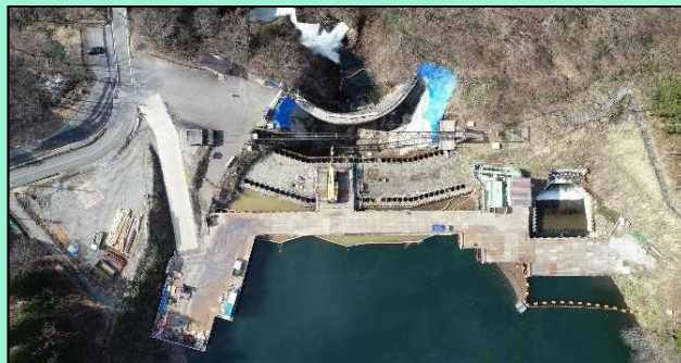
令和2年4月(既設堰堤補強工完了、堰堤掘削中)
