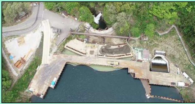
令和元年5月(仮締切完成(水替完了))
