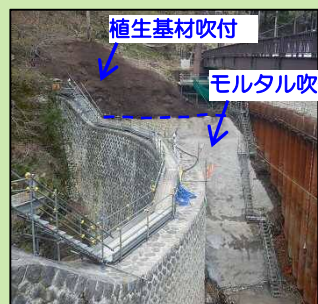
植生基材吹付とモルタル吹付 濁水防止フィルター設置
