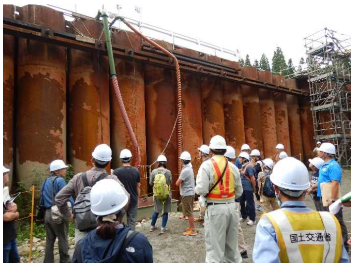
工事現場内を見学
