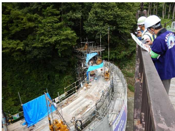
希望大橋から工事現場を見学
