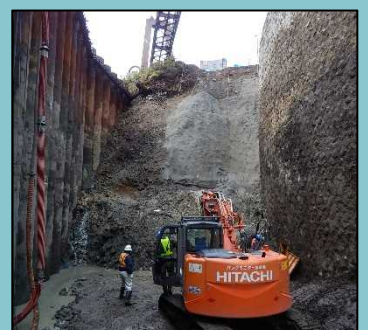
12月末掘削完了状況
