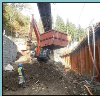
新堰堤部掘削工 施工状況
