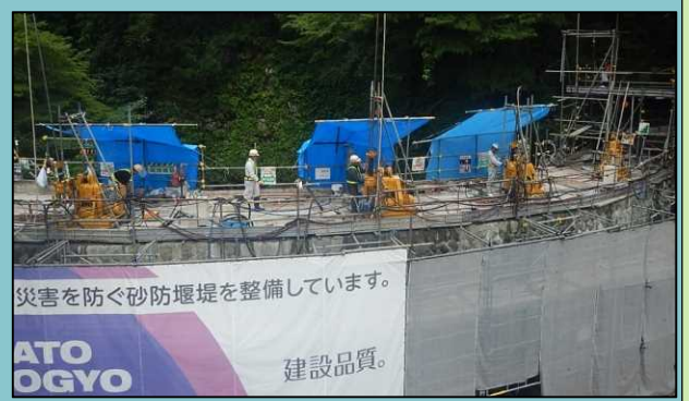
堰堤補強工（グラウチング）
