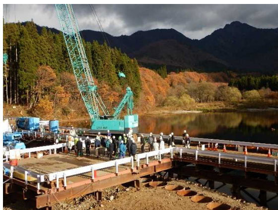
仮栈橋上での説明と大源太山
