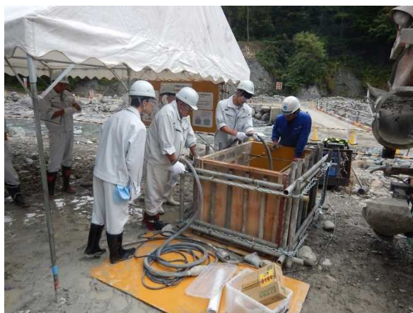
コンクリート打設体験
