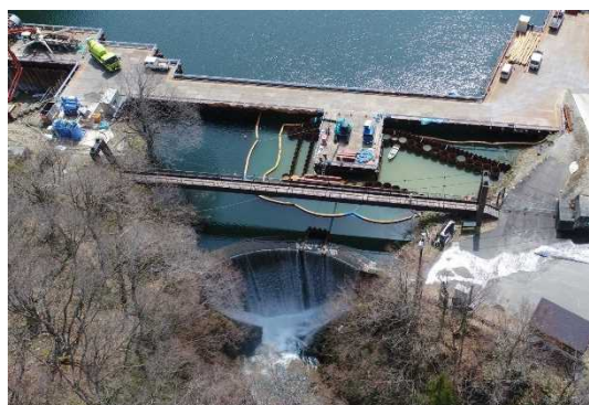
補強工事が進む 大源太第1号砂防堰堤
