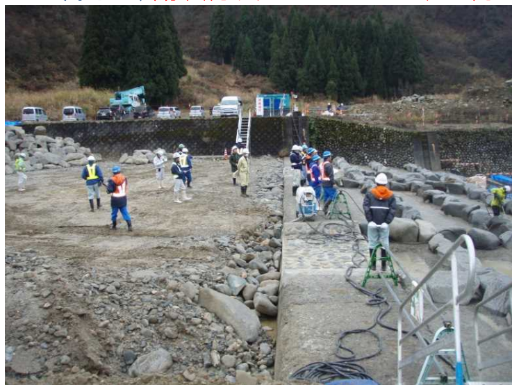
登川流路工第9号床固工深掘対策工事 点検状況
