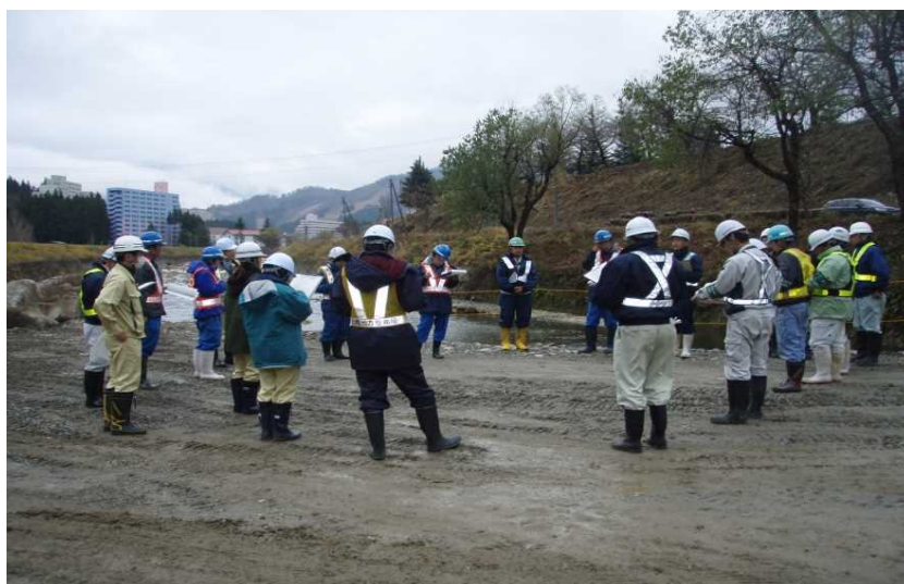
大源太川流路工改築その2工事 点検後意見交換
