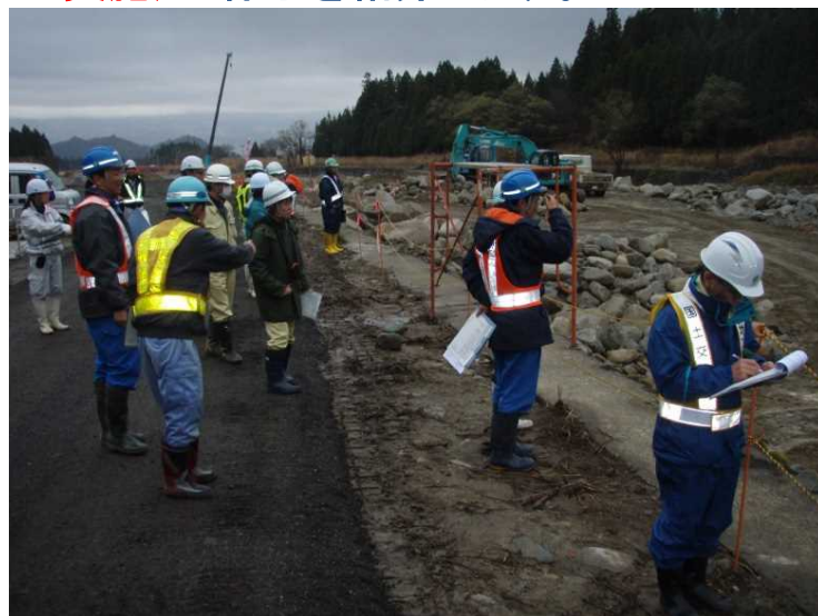
登川流路工第6号床固工深掘対策他工事 点検状況
