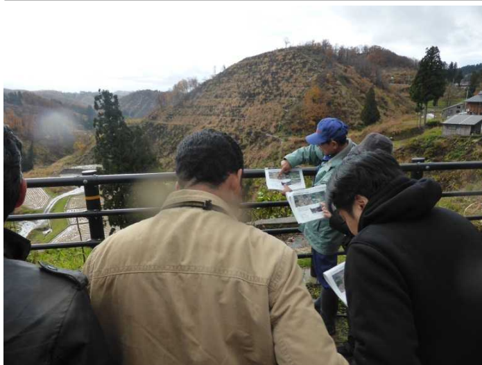
南平地区の砂防・地すべり対策現場
