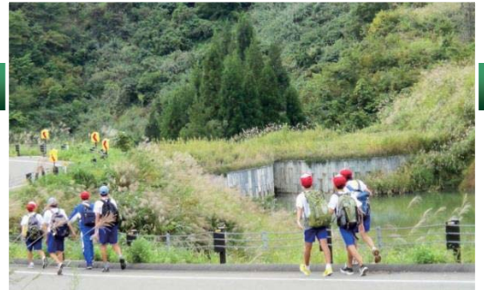
国道291号線から見える 神沢川砂防えん堤
