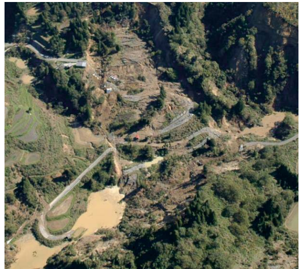
被災直後の寺野地区地すべり
