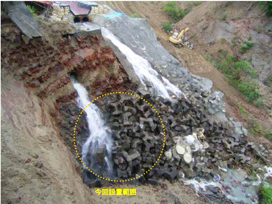
コンクリートブロック設置完了状況 (平成17年7日4日)
