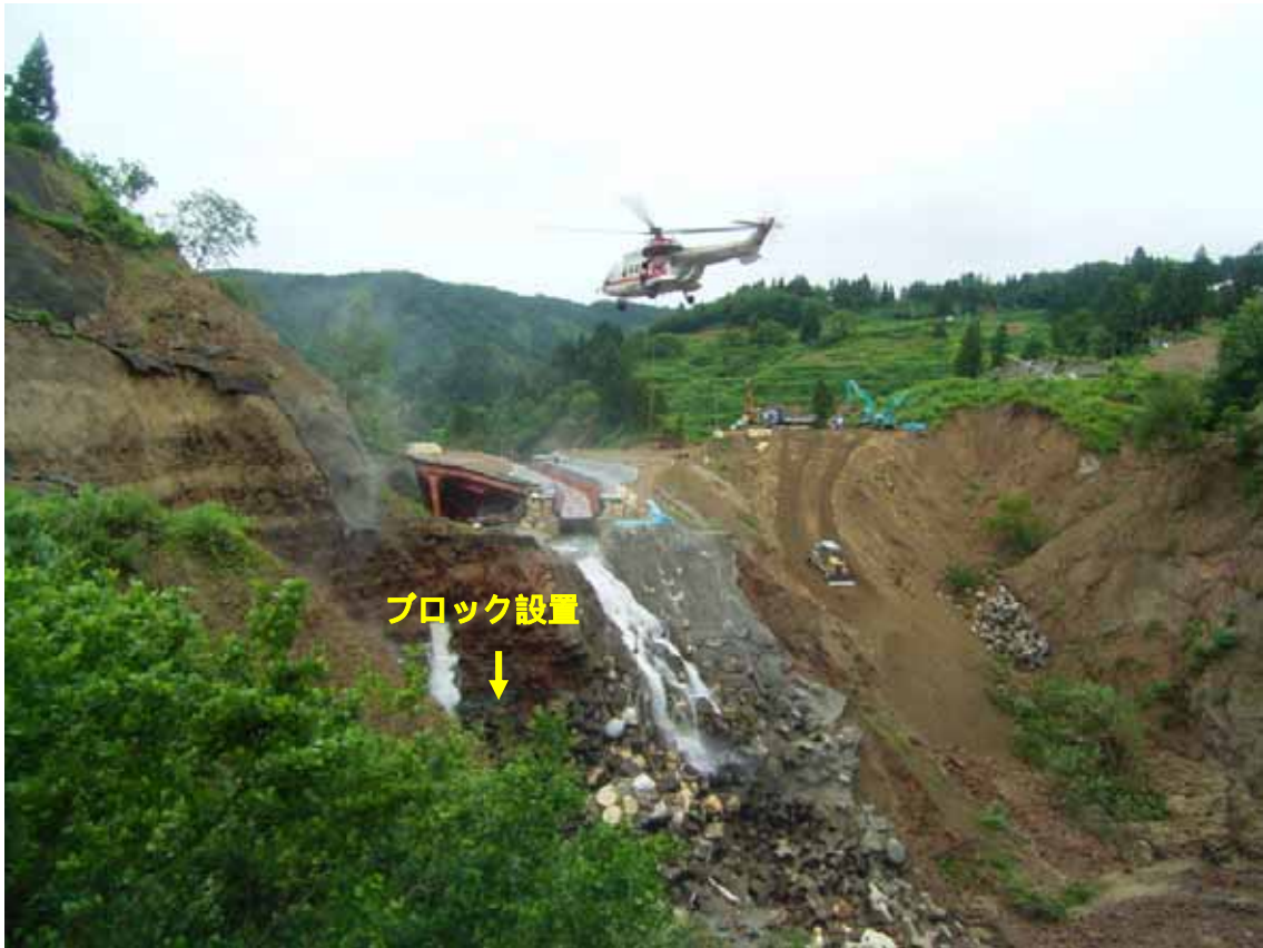
ヘリコプターによるコンクリートブロック設置状況 (平成17年7日4日)
