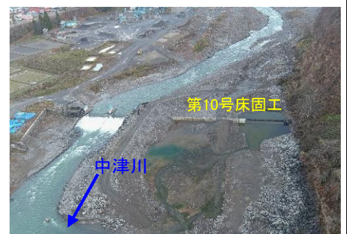
第10号床固工の施工状況
