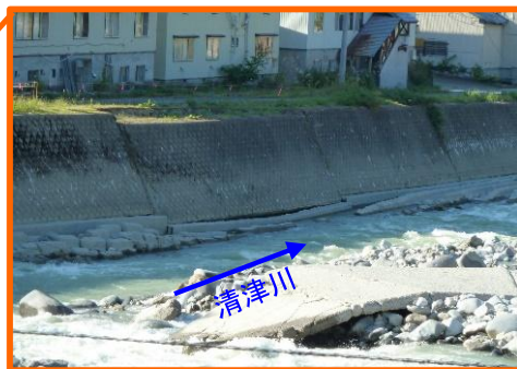
平成25年9月 台風18号で護岸が被災
