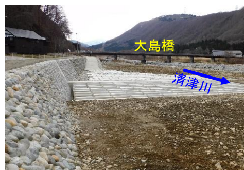
三俣溪流保全工の施工状況
