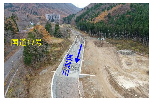
浅貝川溪流保全工の施工状況
