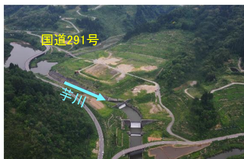
東竹沢砂防堰堤群
