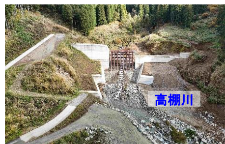
高棚川上流砂防堰堤の施工状況
