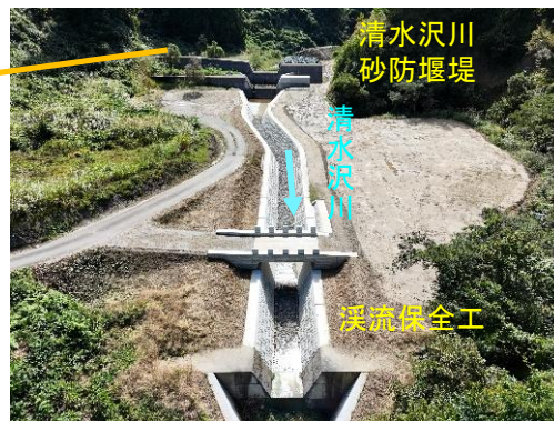
清水沢川砂防堰堤の施工状況
