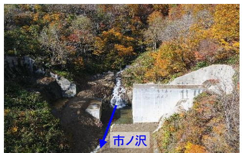
市ノ沢第1号砂防堰堤の施工状況
