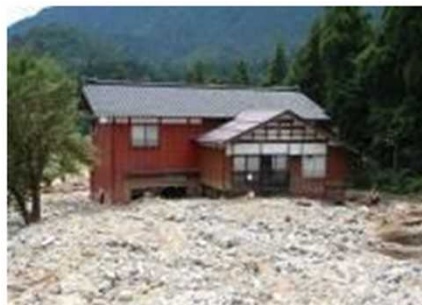
平成23年7月新潟・福島豪雨による 人家の被災(土沢地区)
