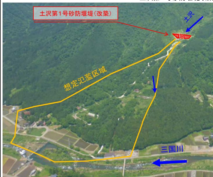
土沢第1号砂防堰堤改築
