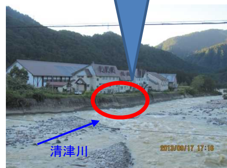
平成25年9月 台風18号による増水に伴う土砂移動で護岸が被災
