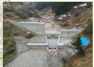
整備中の源太山砂防堰堤
