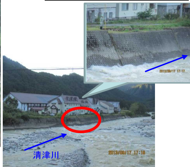
平成25年9月 台風18号による増水に伴う土砂移動で護岸が被災
