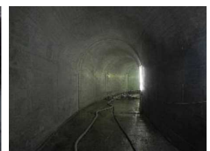
H29年度 排水トンネル着手
