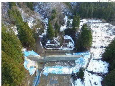
整備中の大形砂防堰堤
