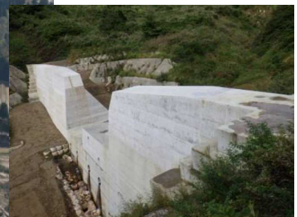
整備中の南平アシ沢砂防堰堤
