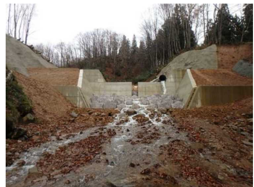
整備中の市ノ沢第2号砂防堰堤
