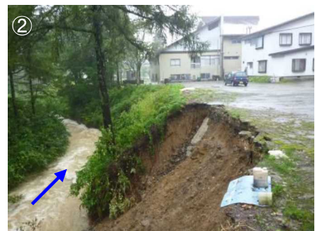
H23.8 台風12号豪雨による増水水状況
