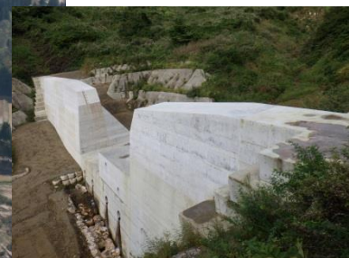
整備中の南平アシ沢砂防堰堤
