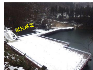
H28年度仮栈橋竣工
