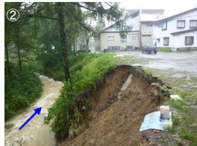
H23.8 台風12号豪雨による増水水状況
