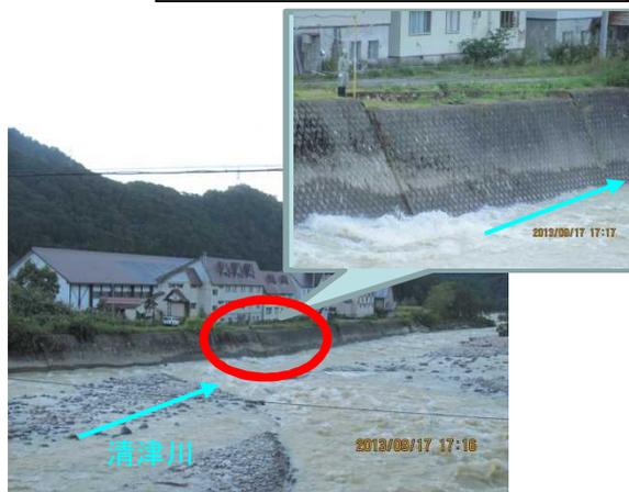
平成25年9月 台風18号での増水により護岸が被災
