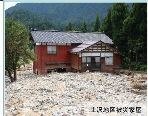
被災した溪流直下流の家屋
