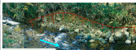
左岸溪岸侵食状況
