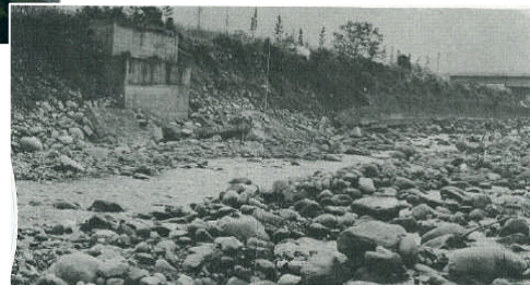
S56. 8月出水による土砂流出
