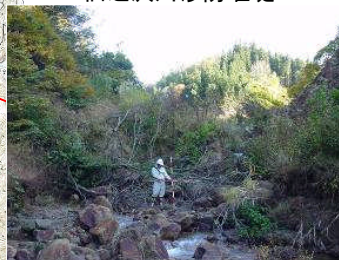
仙之沢川砂防堰堤
