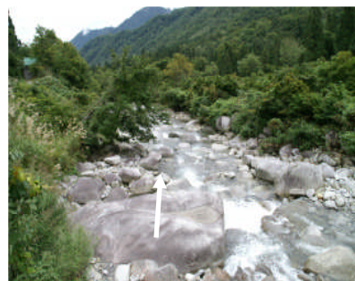
毛渡沢上流域に堆積している不安定土砂（巨礫）
