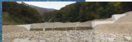
施工中の檜倉沢第2号砂防堰堤
