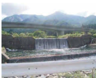
関越自動車道
