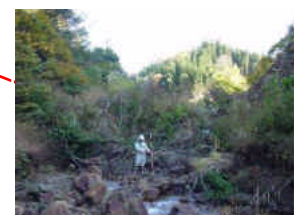
仙之沢川砂防堰堤
