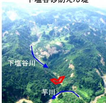
下塩谷砂防えん堤
