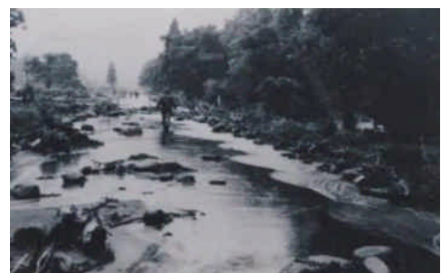
登川堤防決壊による被害状況(S56.8)
