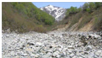
不安定土砂堆積状況
