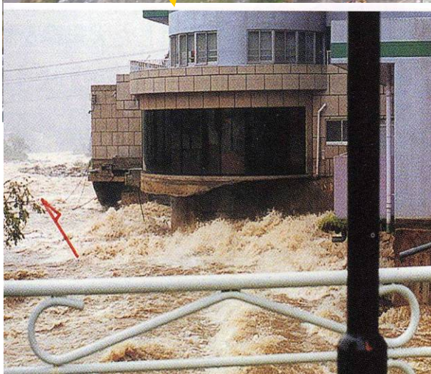
H10年9月松川下流護岸決壊(マンション基礎洗掘)
