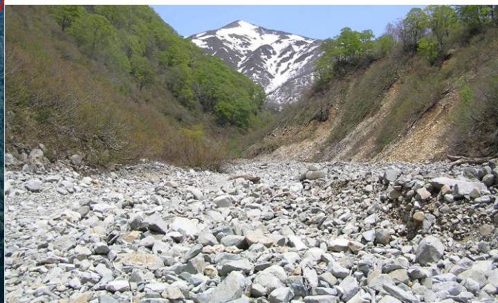
不安定土砂堆積状況
