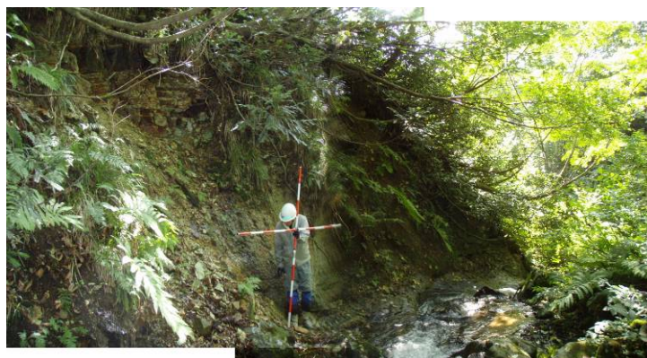
計画地点付近の溪岸侵食の状況
