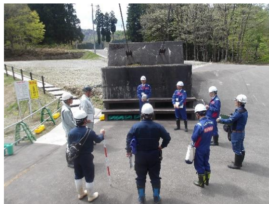
～点検後に状況報告～ 大源太川第1号砂防堰堤周辺(湯沢町)
