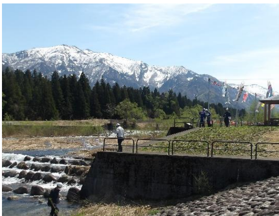
～点検実施状況～ 登川 滝谷橋周辺(南魚沼市)
