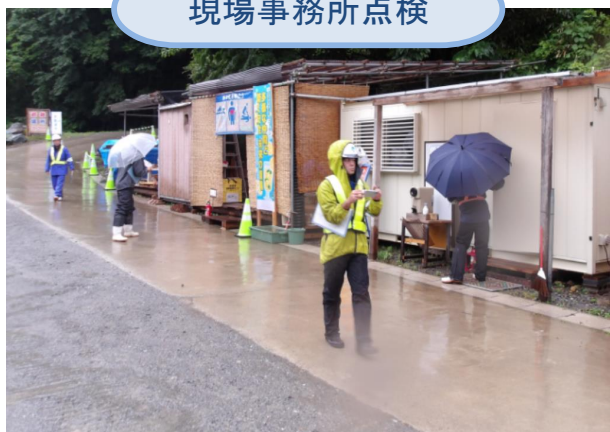
現場事務所点検
