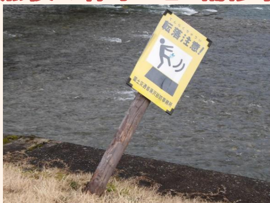
看板の破損(要補修)
