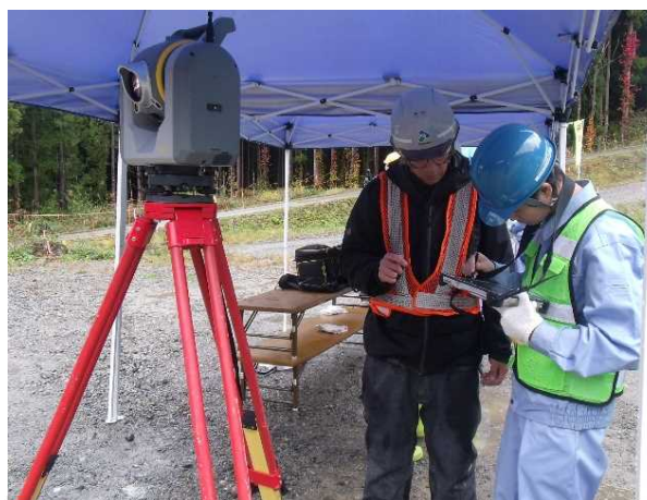
3Dレーザースキャナによる測量体験
