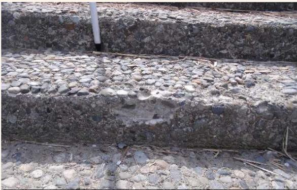
階段の欠損部(要補修)
