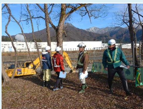
工事現場点検
