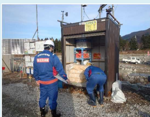
工事現場点検
