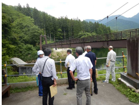
新設堰堤の完成状況確認
