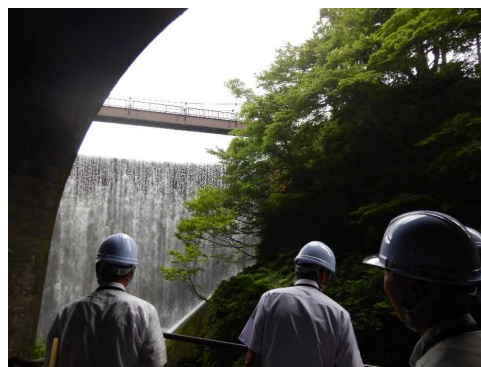
排水トンネルからの眺望確認
