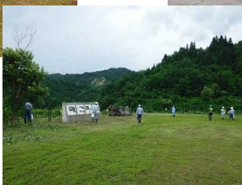
東竹沢砂防堰堤群
