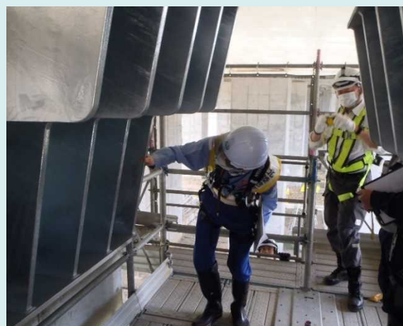
鋼製ブラケットの仮締め状況
