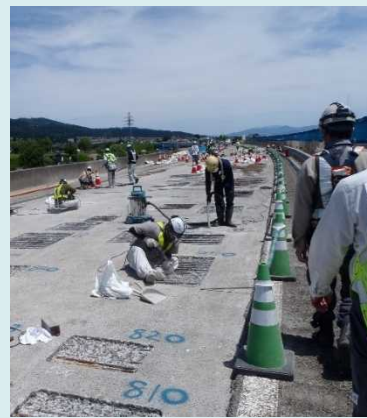
床版補強工事・床版上面補修の状況
