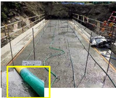
・コンクリート養生用に水タンクと散水ホースによる簡易散水装置を設置することで、休日の現場作業を削減し働き方改革を実現
