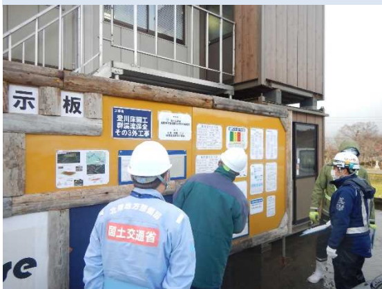
現場事務所のパトロールの状況
