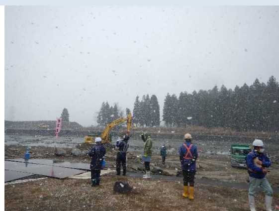
工事現場のパトロールの状況
