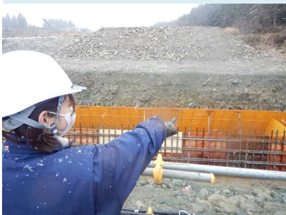
工事現場のパトロールの状況
