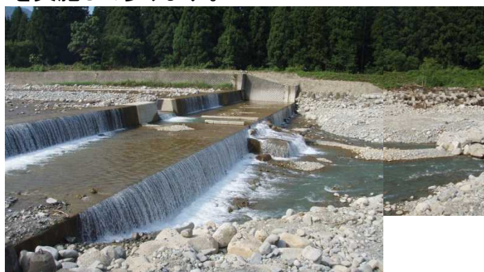
登川流路工第56号床固工の深掘発生状況（H23.8撮影）
