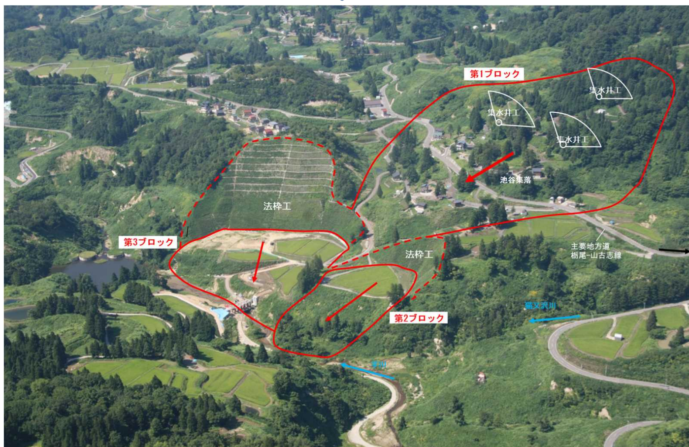
南平池谷地区 地すべり防止工事後の状況（平成24年8月22日撮影）
