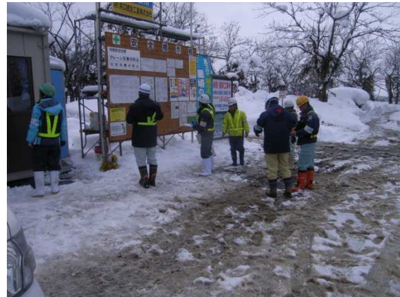
水無川流路工改築工事の点検状況
