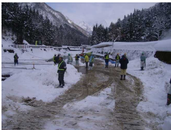
水無川流路工改築その2工事の点検状況
