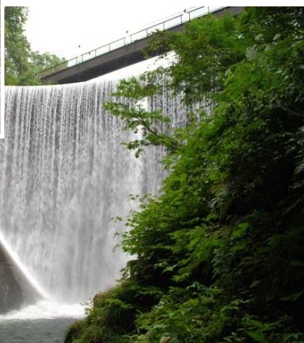
大源太川第1号砂防堰堤
