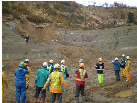
南平アシ沢砂防堰堤本体工事の点検状況
