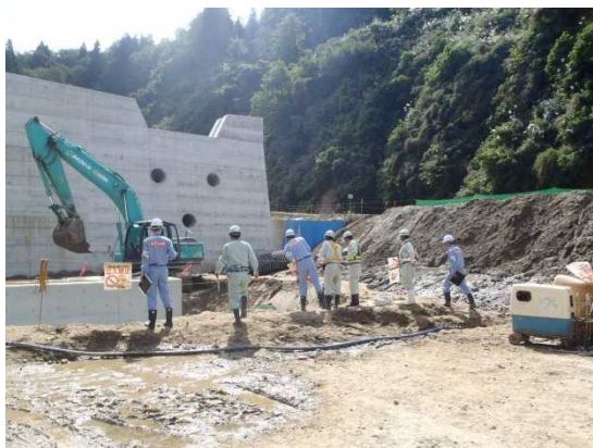
小松倉前沢地区地すべり対策工事の点検状況
