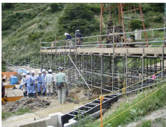
池谷地区地すべり対策その2工事の点検状況
