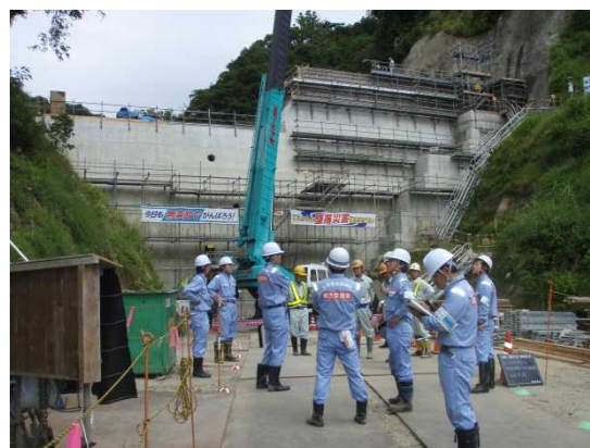
西願寺川上流砂防堰堤工事の点検状況
