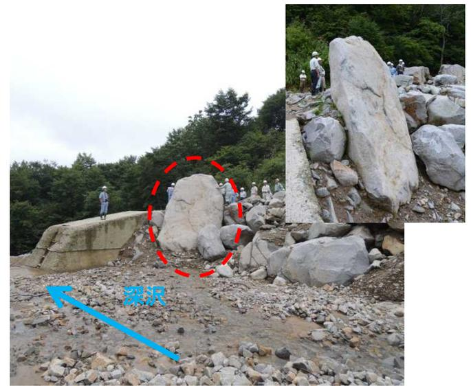
6m(推定)を超える巨石(!)を捕捉している深沢第3号砂防堰堤
