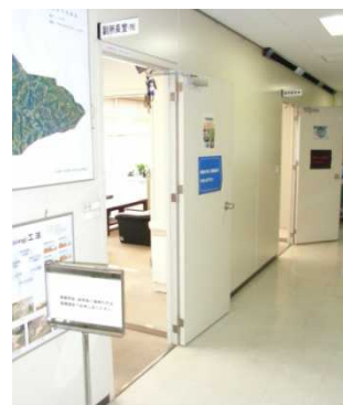
扉撤去後 廊下側から望む
