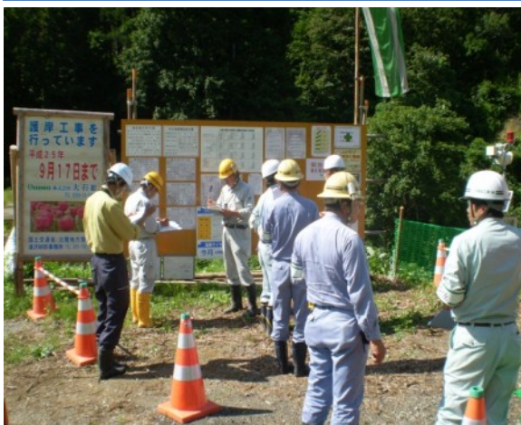
相川川上流第2号砂防堰堤護岸工事 (工事現場掲示物)の点検状況
