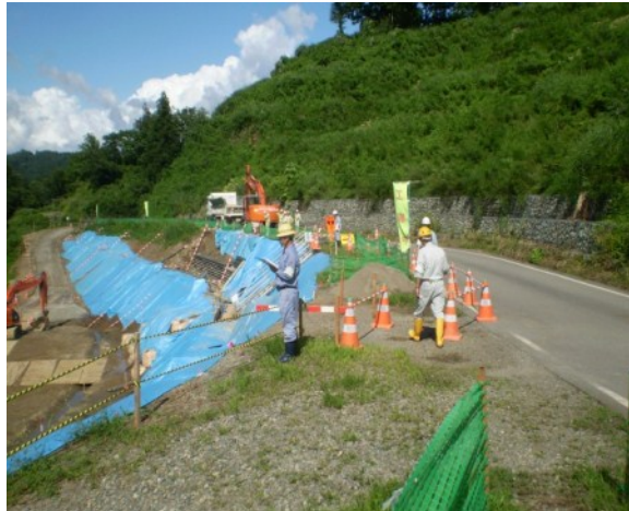
相川川上流第2号砂防堰堤護岸工事 (工事現場)の点検状況
