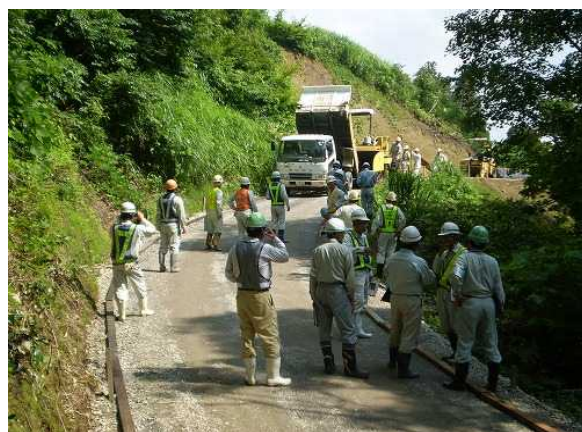
上塩谷地区地すべり対策工事の点検状況
