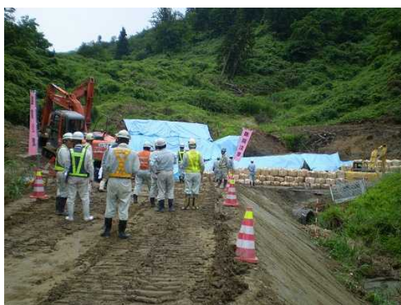
上塩谷地区地すべり対策その2工事の点検状況
