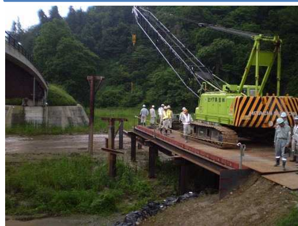
冷子沢第2号砂防堰堤外工事の点検状況
