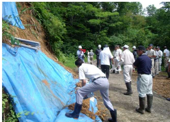
応急対応にて実施した水抜き工を視察
