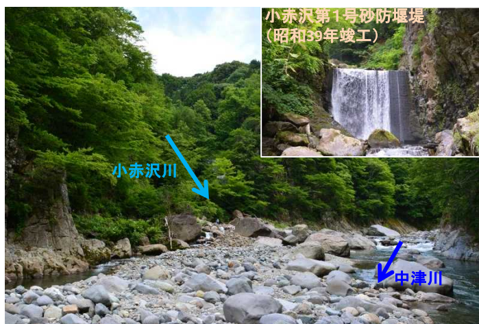
小赤沢川と中津川の合流点に降り、小赤沢の基幹的な施設である小赤沢第1号砂防堰堤についても確認。
